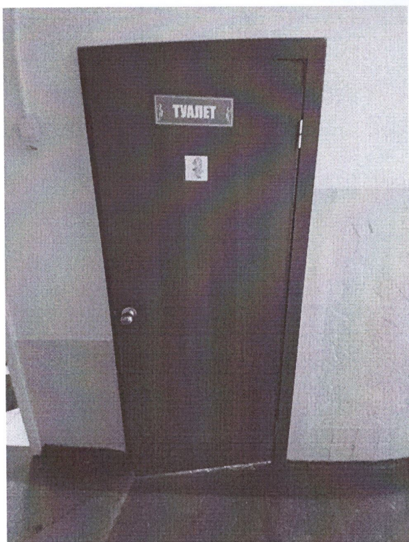
Входная дверь в туалет шириной 780 мм.
